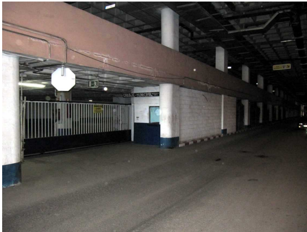
Entrada a zona de aparcamiento Ayuntamiento de Monachil.
