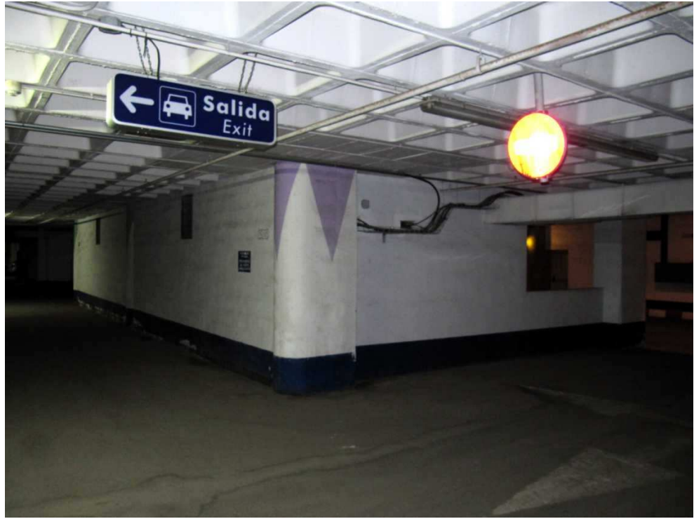
Zona 7 estado actual, vista posterior.
