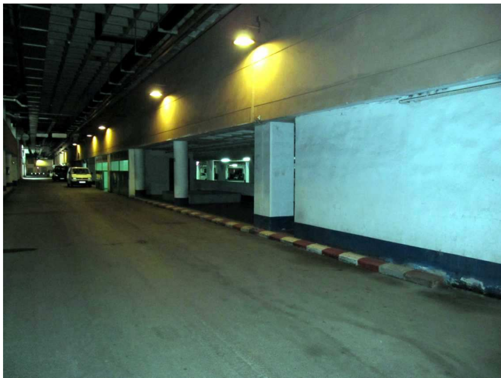
Zona 4 estado actual, vista longitudinal.
