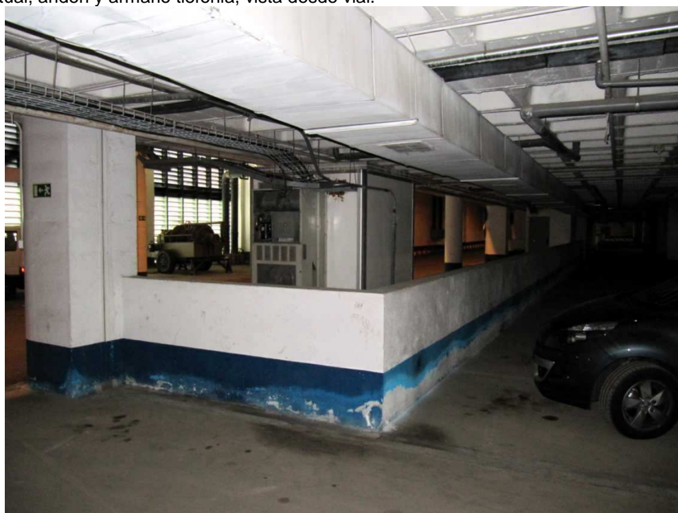
Zona 8 estado actual, anden y armario telefonía, vista posterior.
