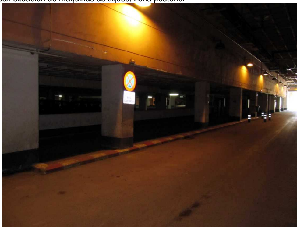
Zona 3 estado actual, vista longitudinal.
