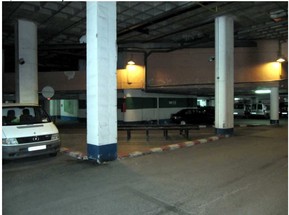
Zona 6 estado actual, vista de zona de isleta.
