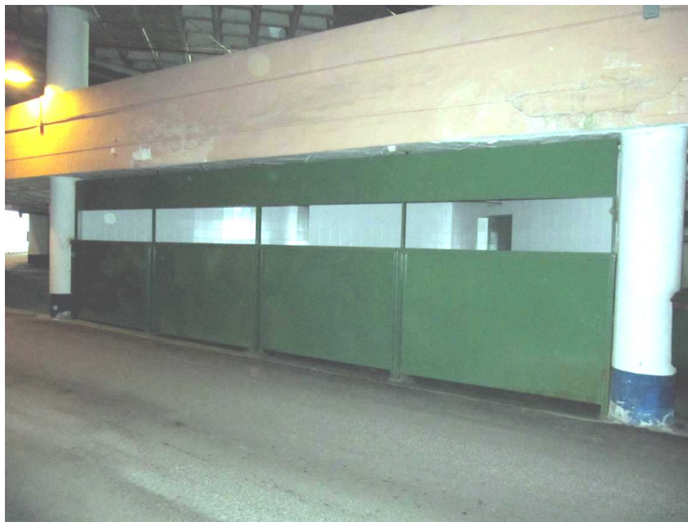
Eliminación de carpintería metálica y cerramiento de bloque.
