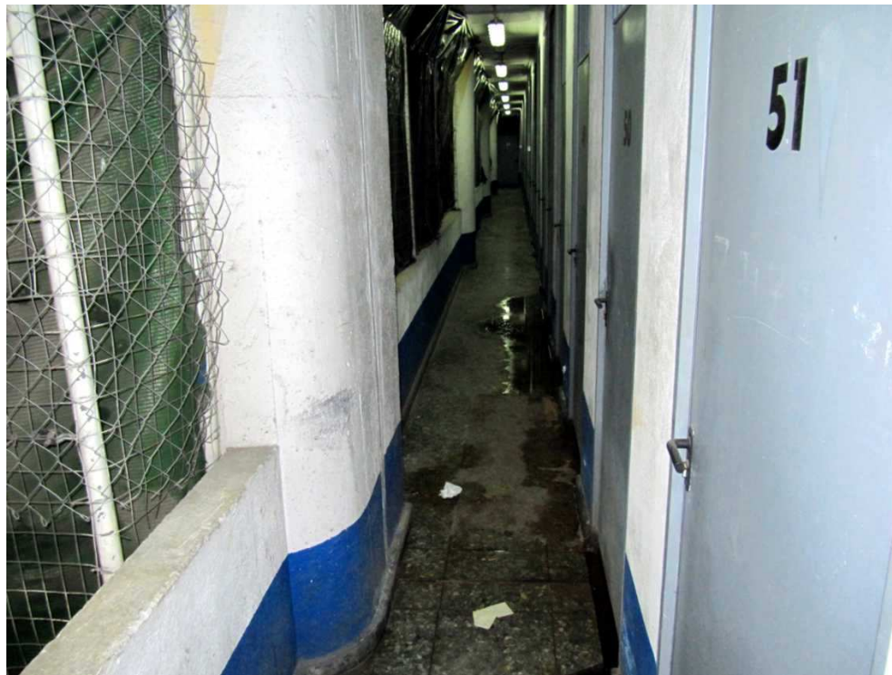
Zona posterior estado actual.
