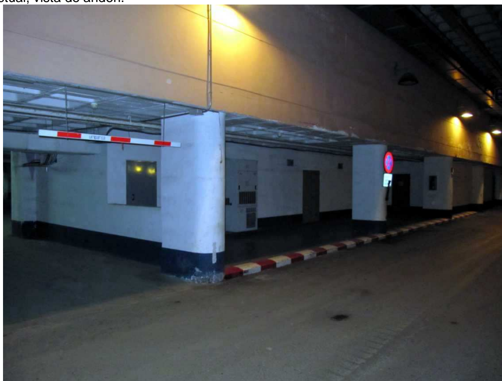
Zona 7 estado actual, vista de anden.
