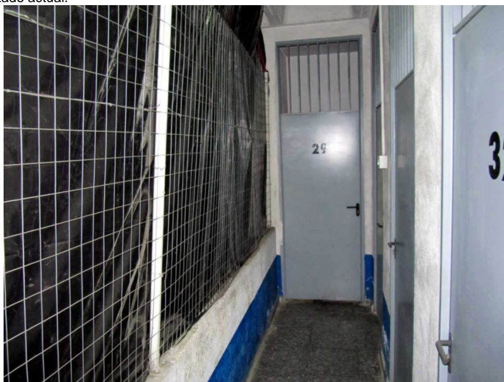
Zona posterior estado actual.
