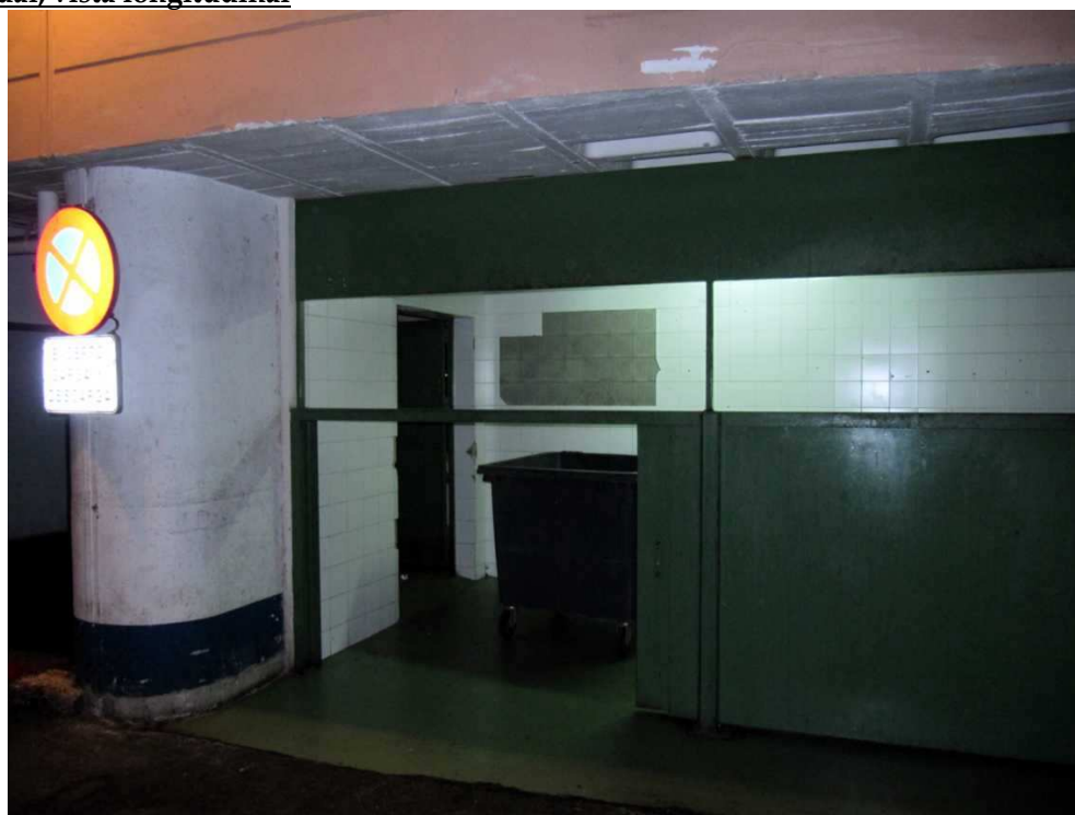
Zona 7 estado actual, vista cuarto basuras.
