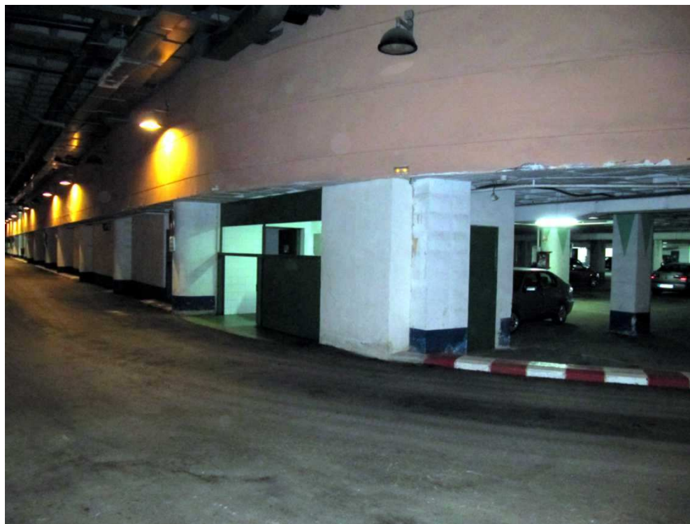
Zona 7 estado actual, vista longitudinal
