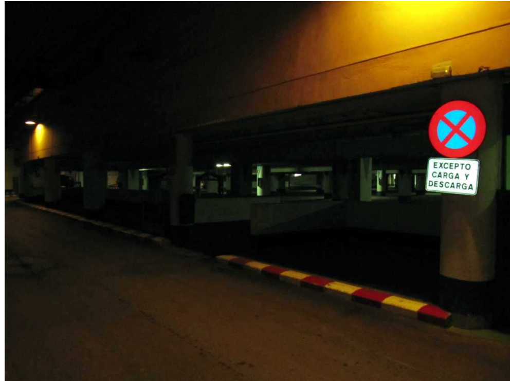
Zona 9 estado actual, vista logitudinal de andenes.
