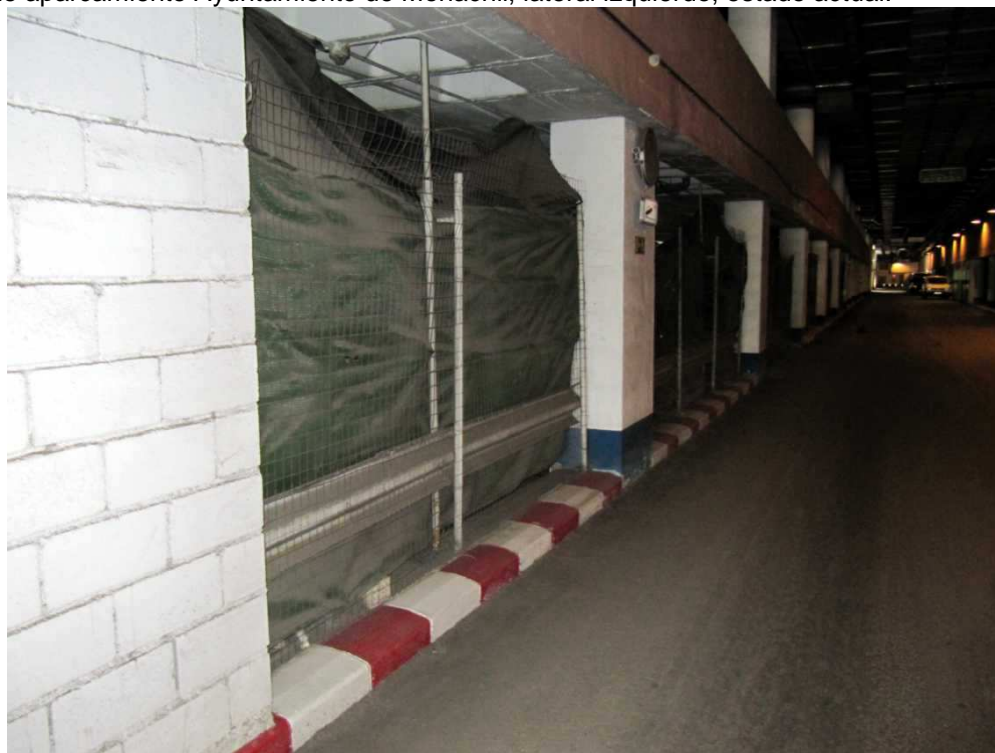
Frente estado actual, desde control.
