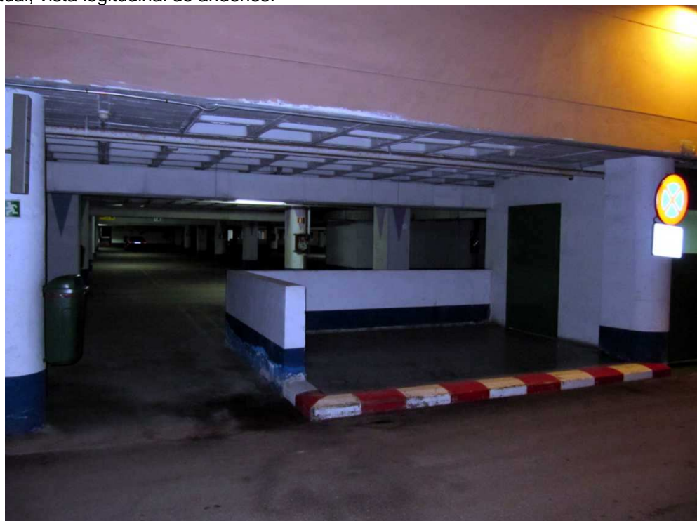
Zona 9 estado actual, anden independiente junto a cuarto de basuras.
