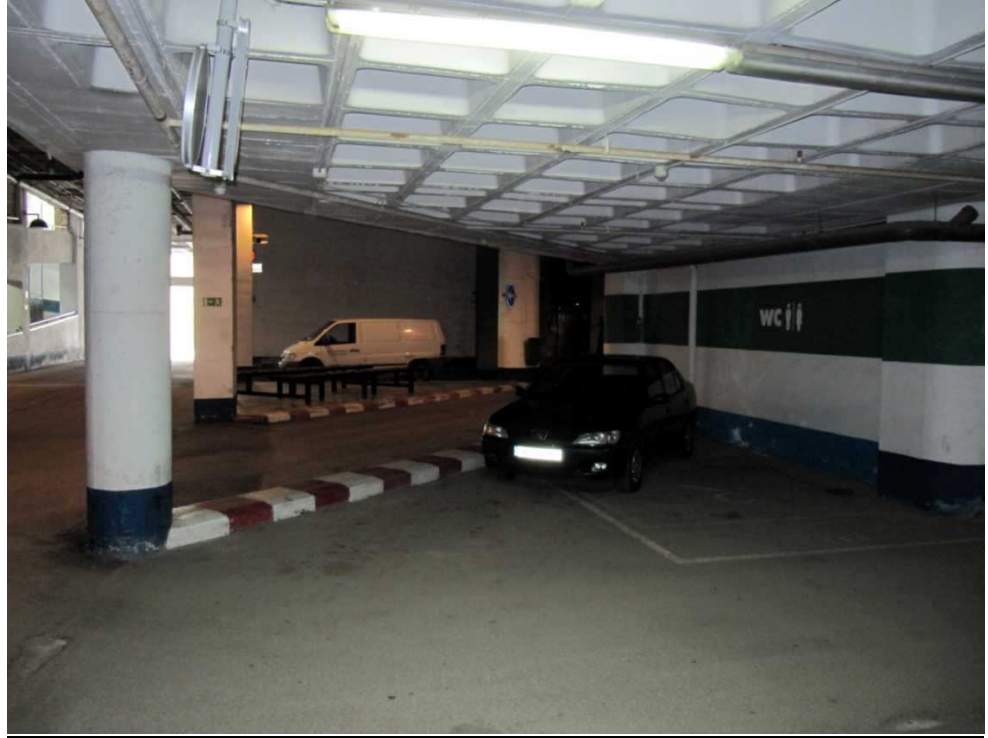
Zona 6 estado actual, vista de zona junto a aseos.
