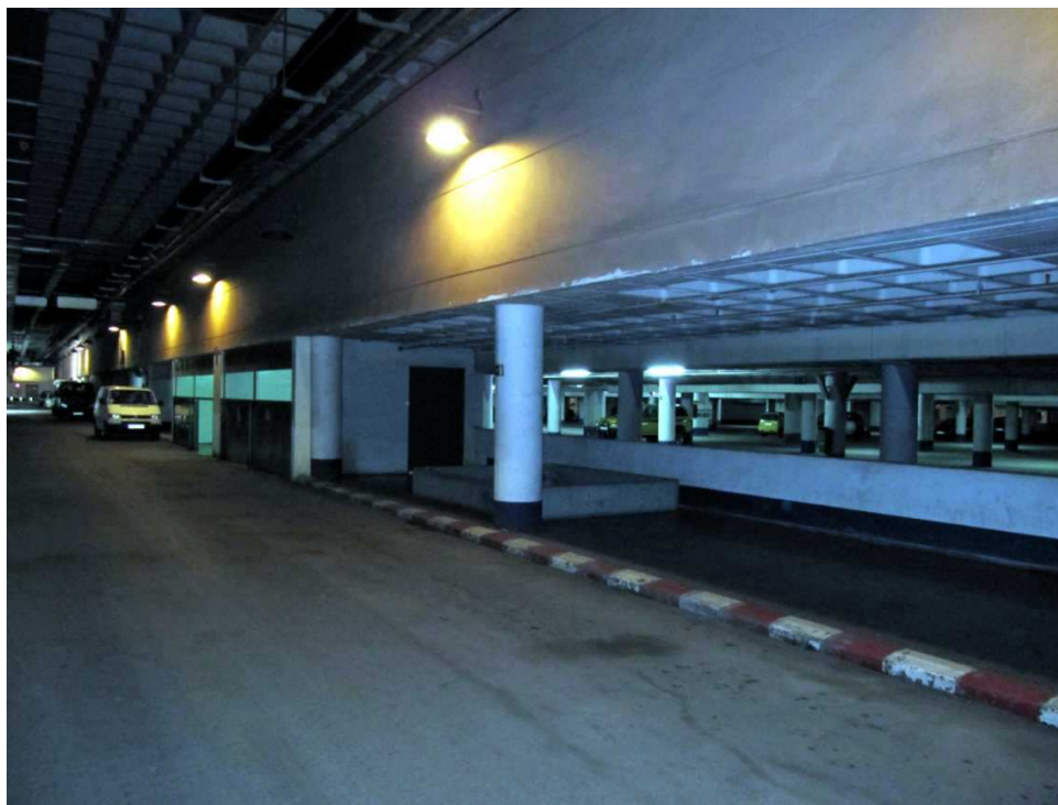
Zona 4 estado actual, anden, vista desde vial.
