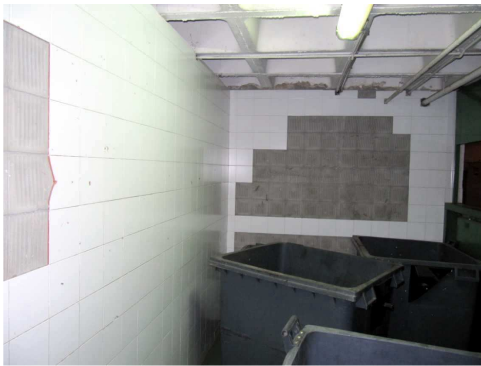
Zona 7 estado actual, vista interior cuarto de basuras.
