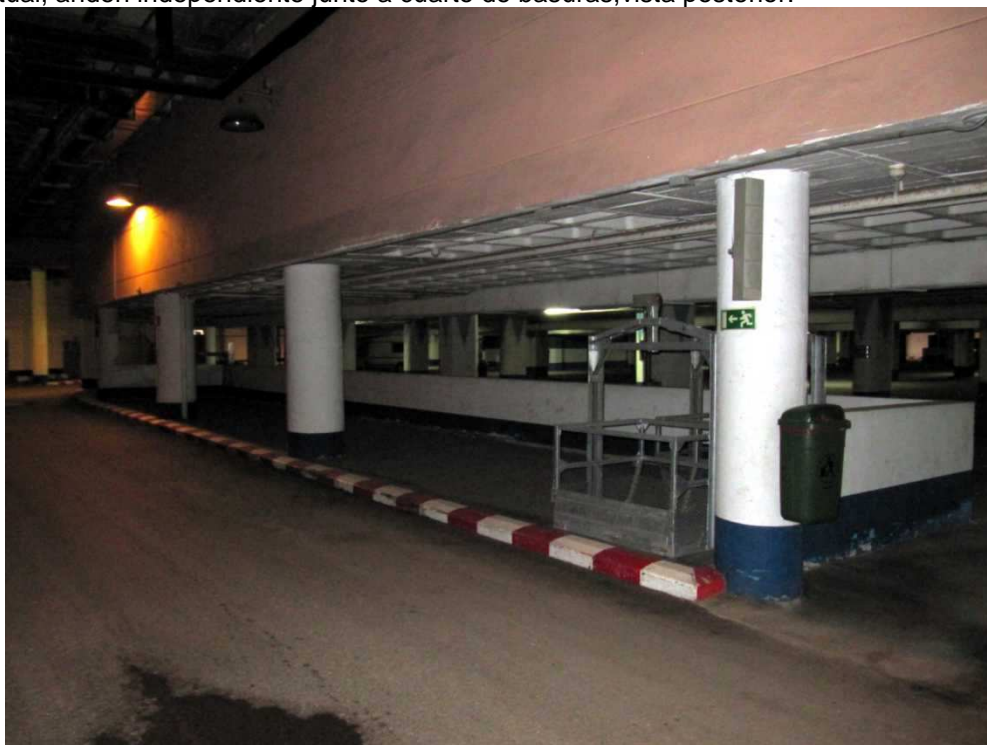
Zona 9 estado actual, anden frente a hotel zirwab.
