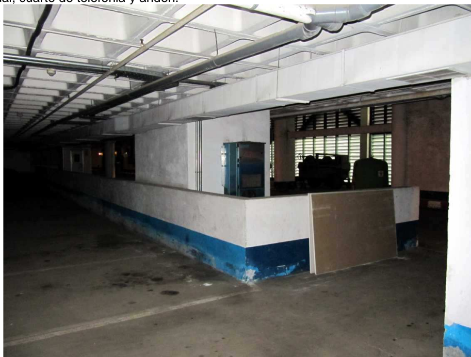
Zona 8 estado actual, cuarto de telefonía y andén, vista posterior.
