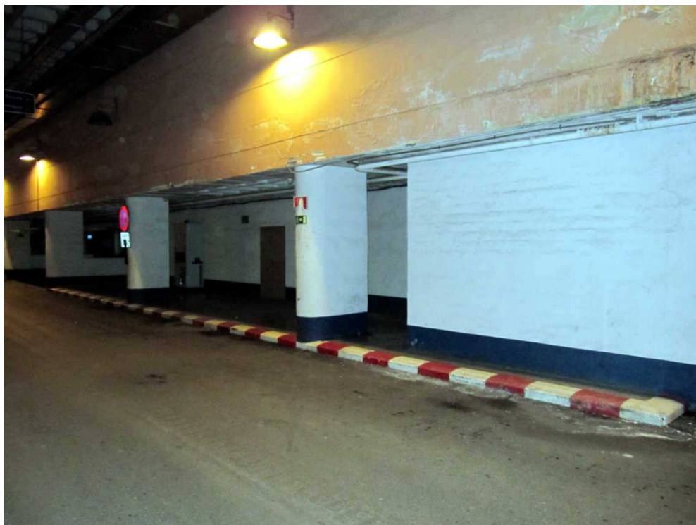
Zona 7 estado actual, vista de anden.
