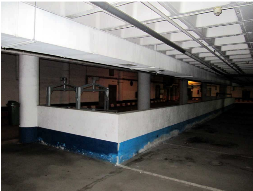
Zona 9 estado actual, anden frente a hotel Ziriyab, vista posterior.
