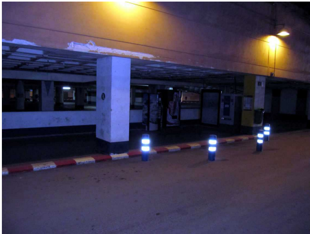
Zona 3 estado actual, situación de maquinas de tiques.
