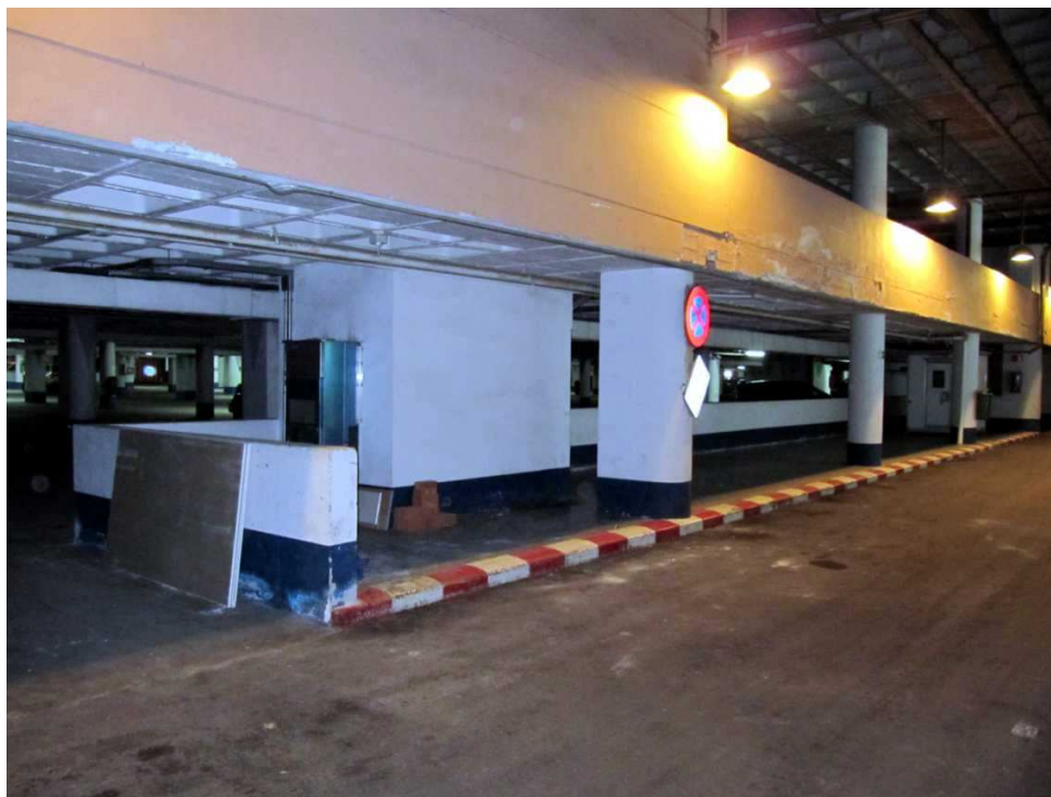
Zona 8 estado actual, cuarto de telefonía y andén.
