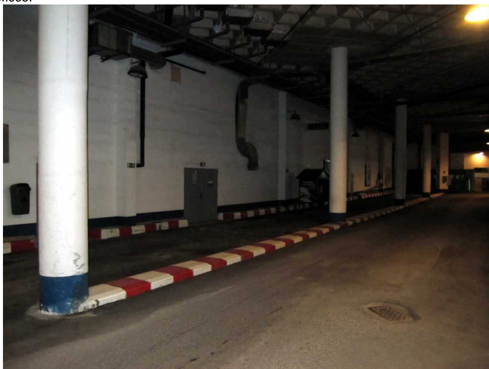
Mediana existente frente a oficce zona 1.
