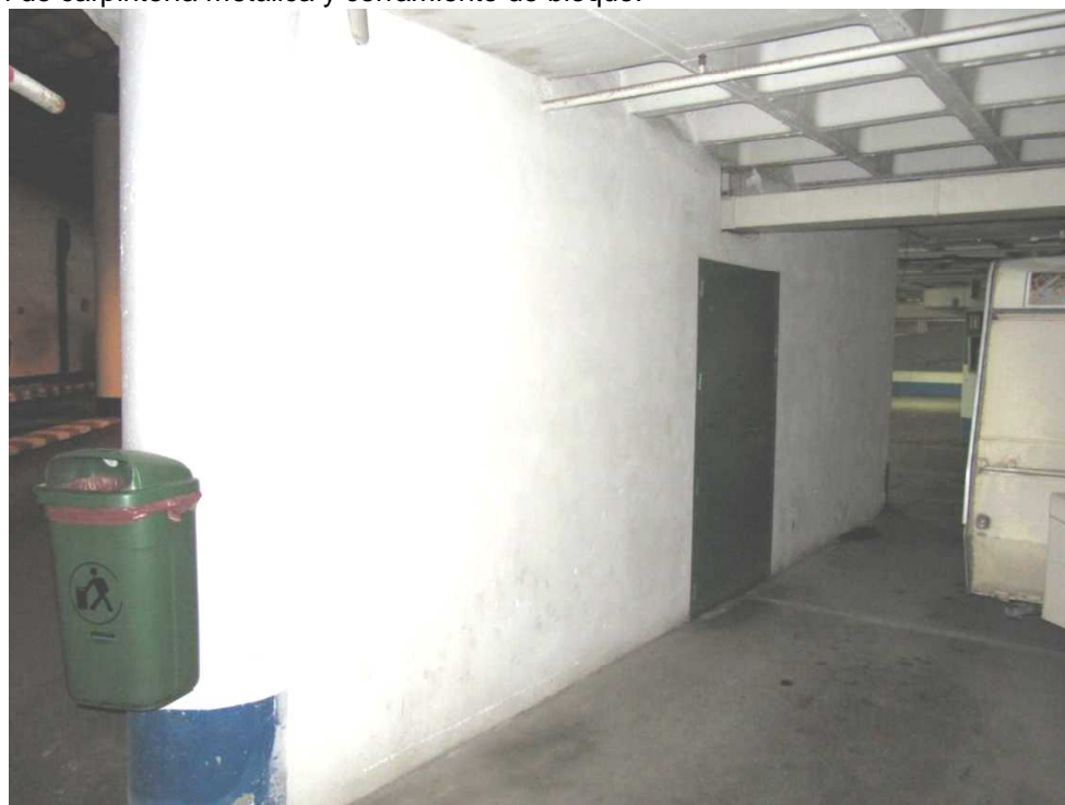
Eliminación de Puerta metálica y cerramiento de bloque.
