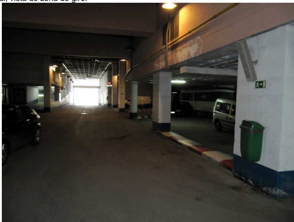
Zona 6 estado actual, vista de salida a edificio de maquinas.
